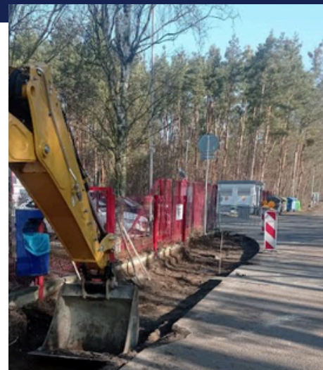
Stavební práce na novém chodníku v ulici Prokopa Holého
