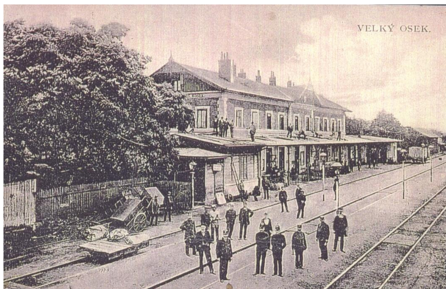
Obrázek 1: Budova nádraží s částí kolejiště kolem r. 1900
