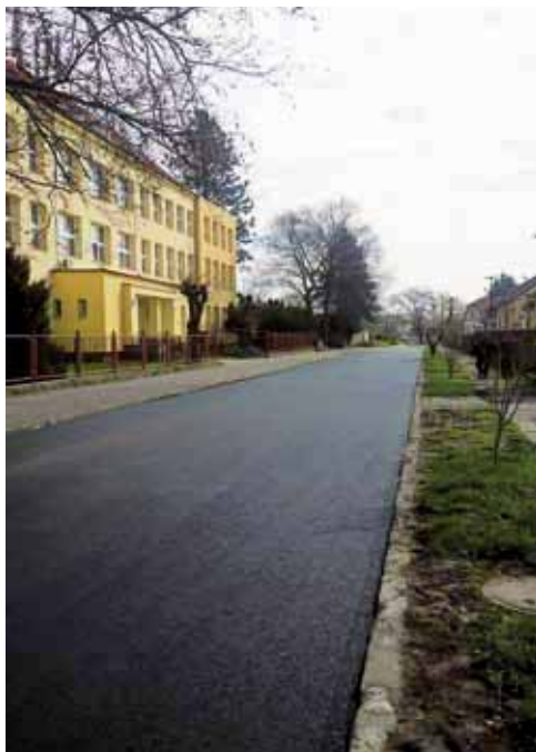
Opravená silnice před základní školou
