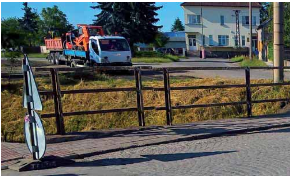
Oprava mostku přes Bačovku u obchodu na Nábřeží
