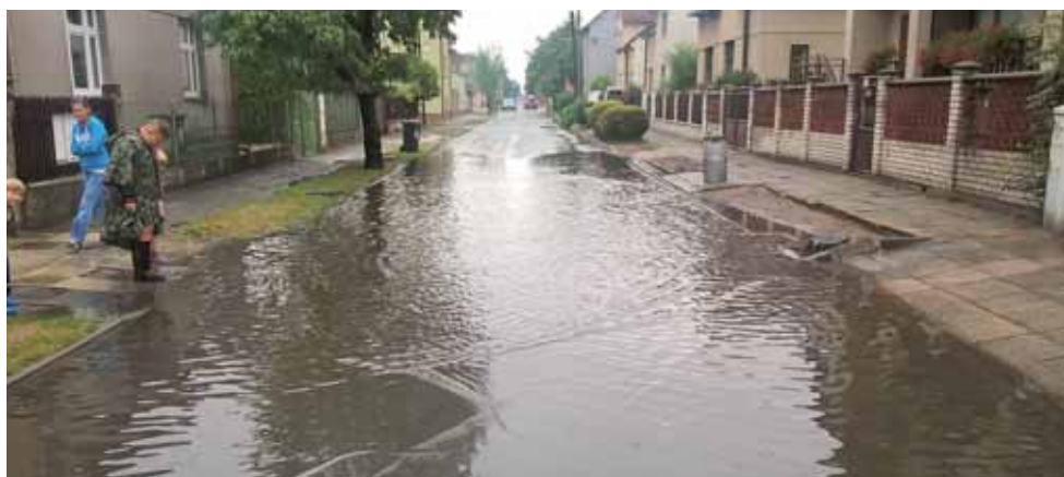
Nefunkční dešťová kanalizace v ulici Komenského
