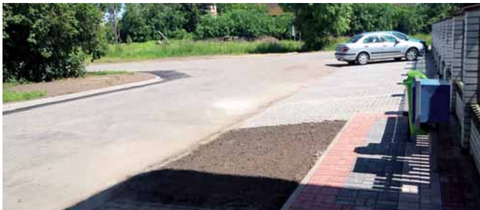
Opravená dešťová kanalizace a parkování u zdravotnického střediska
