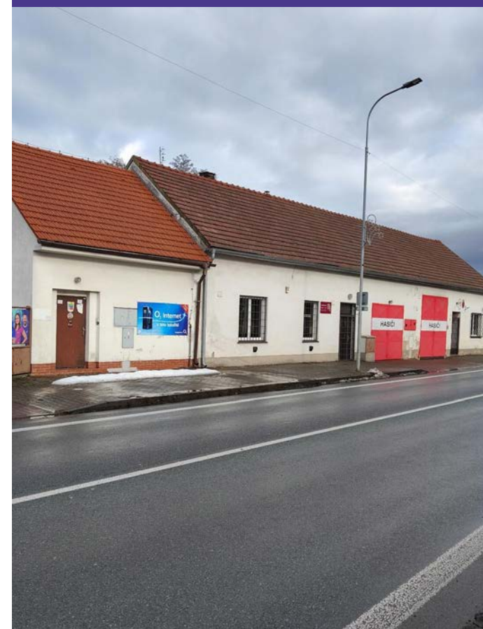
Hasičárna před rekonstrukcí
