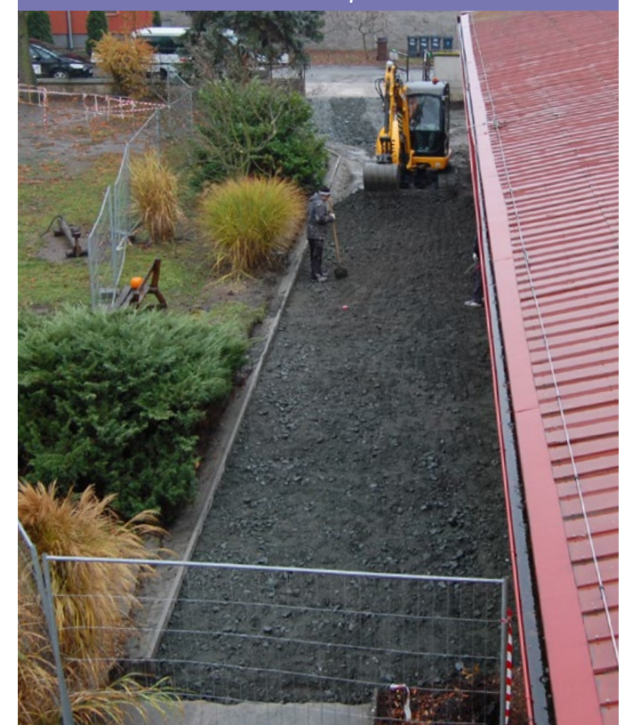
Průběh rekonstrukce chodníku před mateřskou školou
